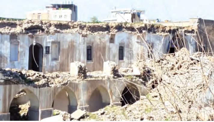
Osmanlı Kışlası'nın yıkılan Bölümleri
